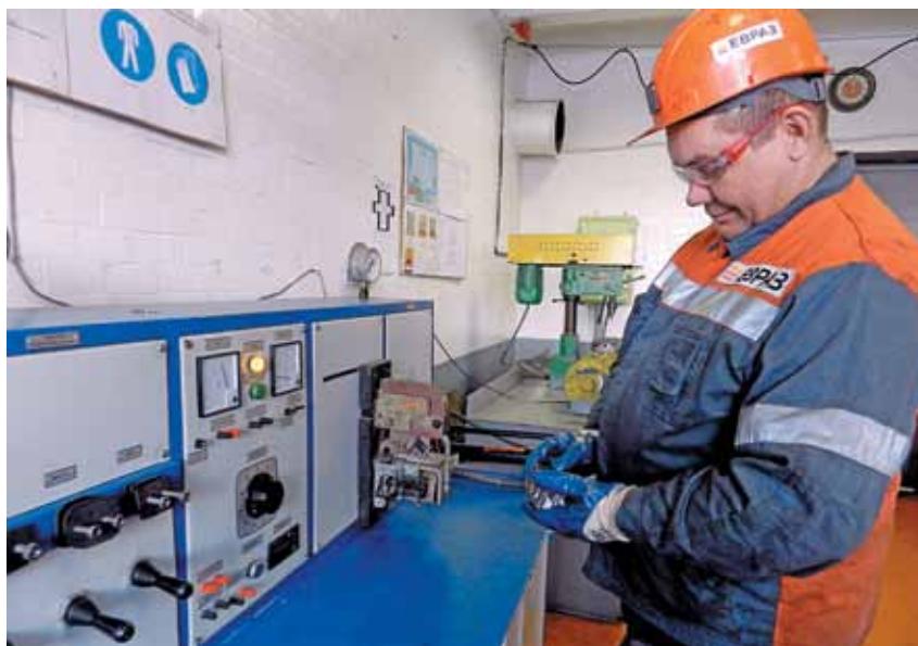
В электроцехе внедрена система вытягивания. Слесарь-электрик Сергей Дектерев проверяет исправность оборудования на стенде
